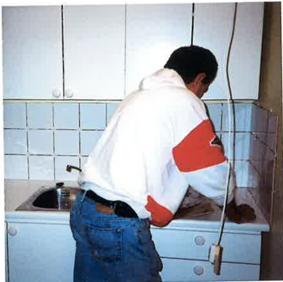
Kjøkkenet monteres og flislegges
